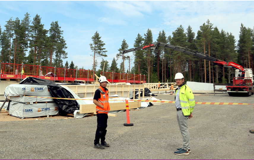
Kultalan rakennustyömaalla rakennetaan parhaillaan kattoelementtejä sokkelin päällä. Seinäelementit tulevat valmiina paloina. Kuvassa työmaajohtaja Antti Niskakangas ja seurakunnan kiinteistöpäällikkö Ville Salmela. Lisää kuvia rakennusvaiheista löytyy seurakunnan nettisivuilta jutun yhteydestä.
